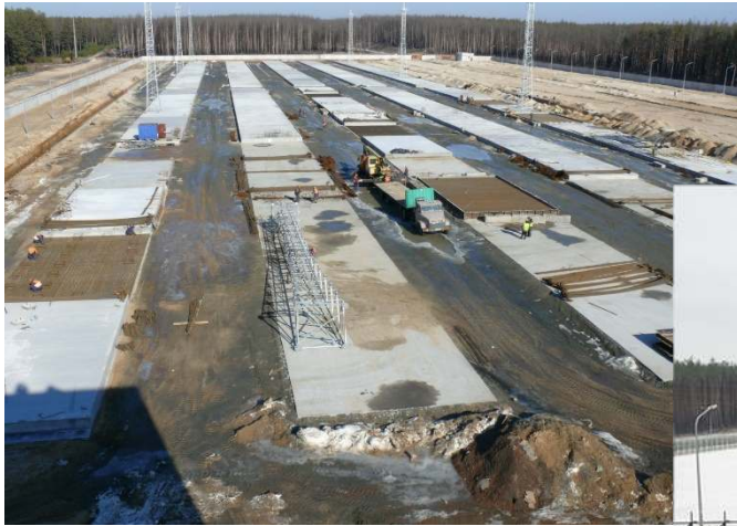
Майданчик ЦСВЯП на початок 2019 року. Будівництво фундаментів для систем зберігання ВЯП
