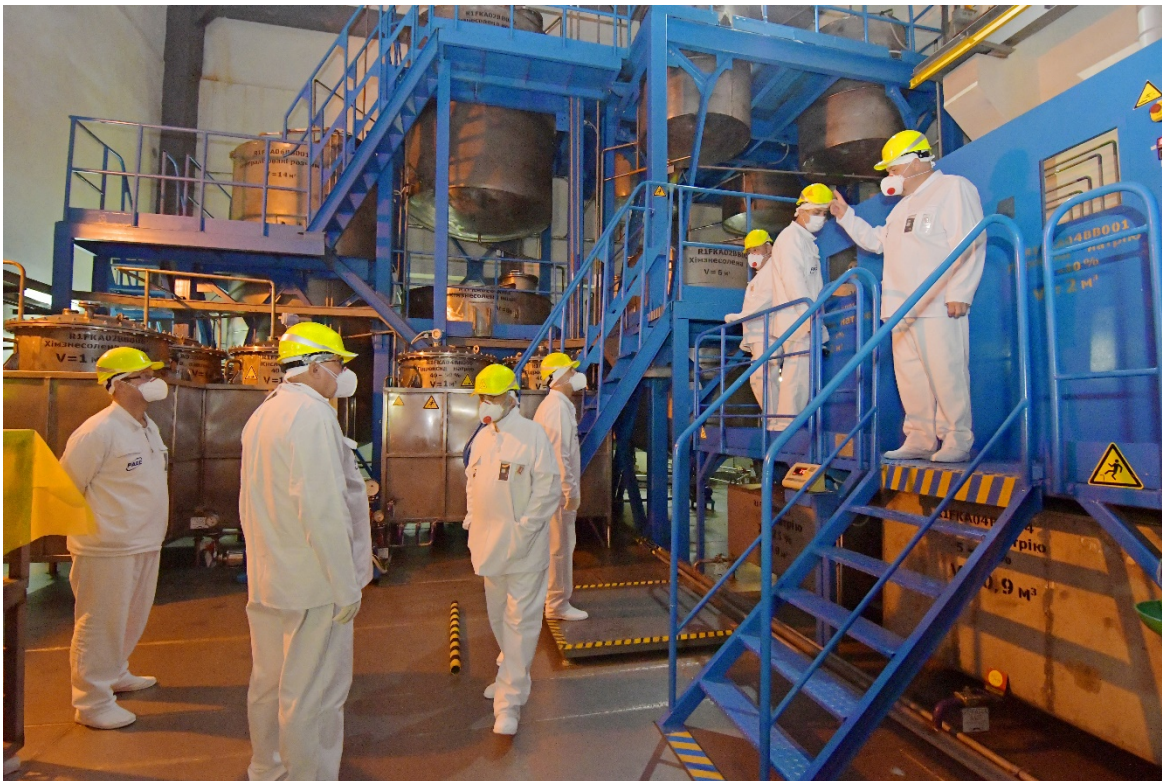
Установка дезактивації металу
