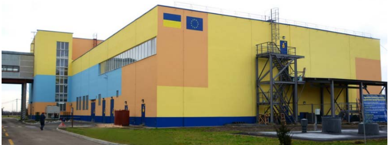
Будівля КПРАВ РАЕС
